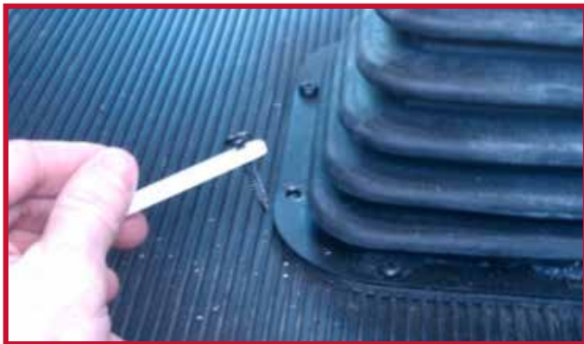
Figura 9 - Instalación del gancho en el tornillo existente
