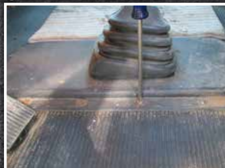
Figura 6 - Extracción del tornillo
