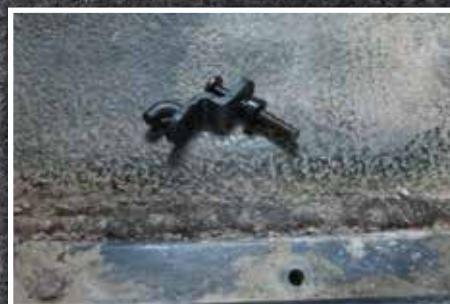
Figura 7 - Conjunto de gancho y espaciador
